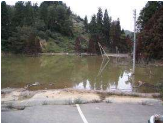
芋川に水没した道路
